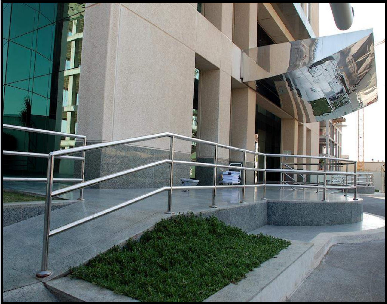
Al Binali Tower Dammam KSA
